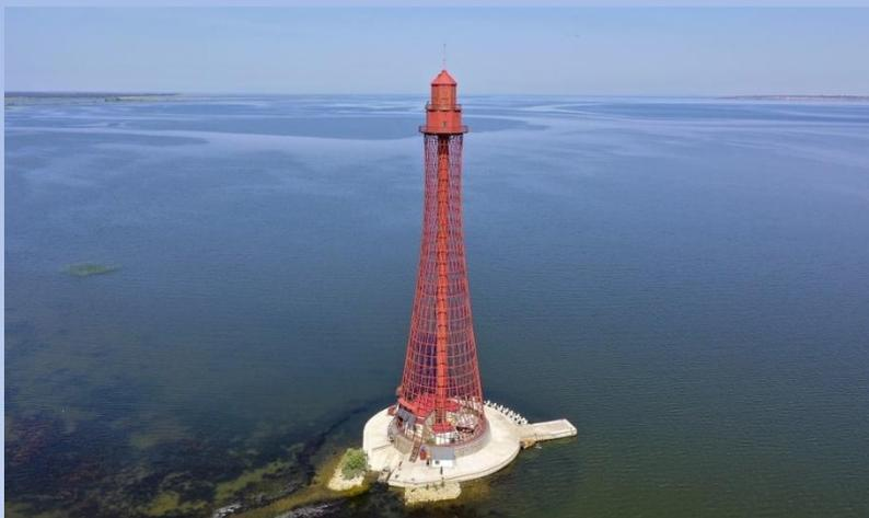
**Аджигольский маяк** – удивительная гиперболоидная конструкция, расположенная в Днепровском лимане. В отличие от традиционных маяков, он своей сетчатой поверхностью больше напоминает телевышку. Спроектировал конструкцию инженер Владимир Шухов, известный также созданием Шаболовской телевизионной башни.
